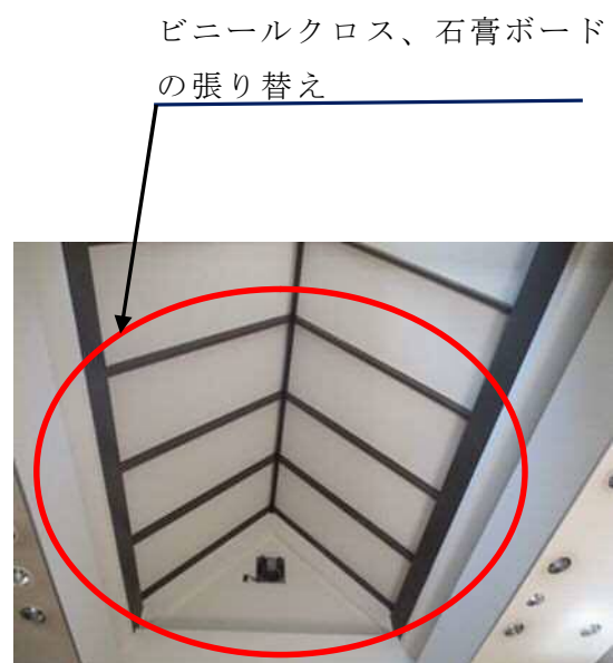
【屋根内側の修繕箇所】
